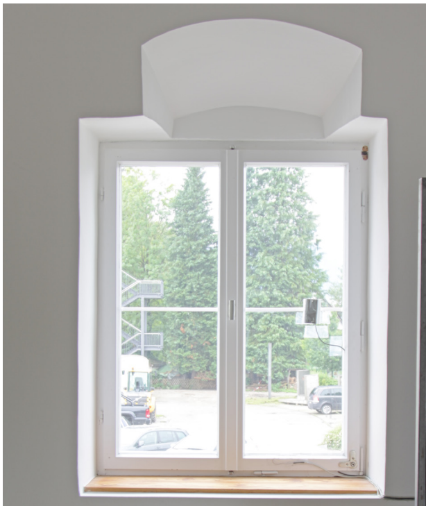
Abb. 10 und 11. Bestandsfenster in Holz mit Austausch der Einfachglasscheibe durch ein Isolierglas (links), Schnittzeichnung (rechts), © Fraunhofer IBP
