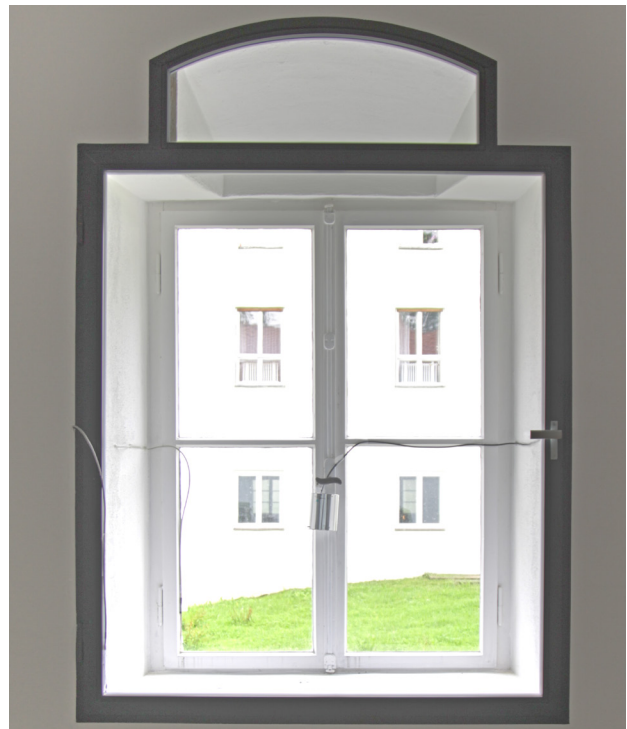
Abb. 11 und 12. Vorsatzfenster mit Metallrahmen, bündig mit der inneren Wandoberfläche montiert, Planung (links) und Umsetzung, © Fraunhofer IBP
