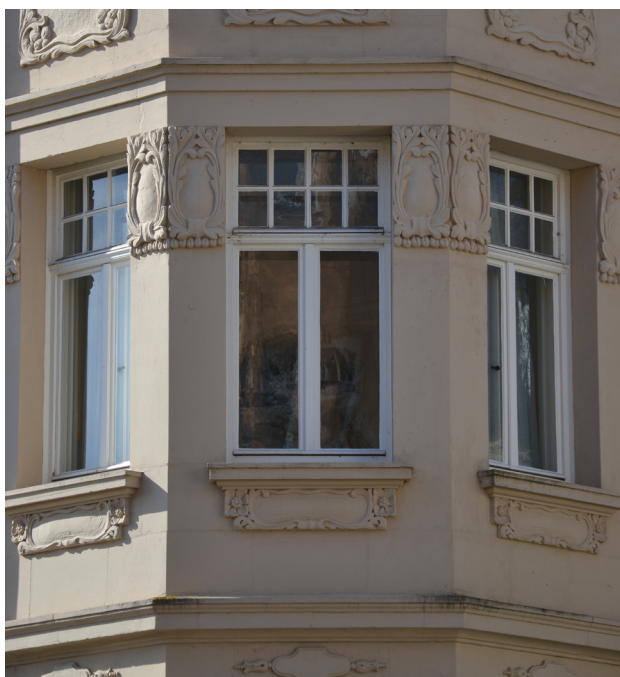
Abb. 4. Historische Fensterteilungen eines Gebäudes in der Ottostraße in Bamberg, © Ruth Tenschert, KDWT
