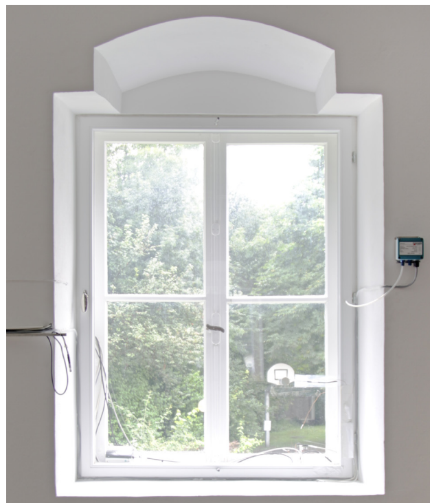
Abb. 15 und 16. Erweiterung eines Bestandsfensters zu einem Holz-Kastenfenster mit Isolierglas, zusätzlich zweite Isolierglasebene durch den Austausch des bestehenden Einfachglases mit einem Isolierglas, ©Holzmanufaktur Rottweil und Fraunhofer IBP
