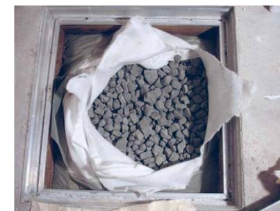
Abb. 3: Revisionsöffnungen zur Entnahme von Schaumglasschotterproben
