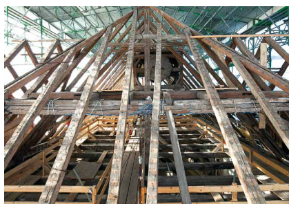
Sanierung des Dachwerks
