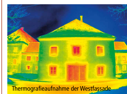
... und nach der Sanierung
