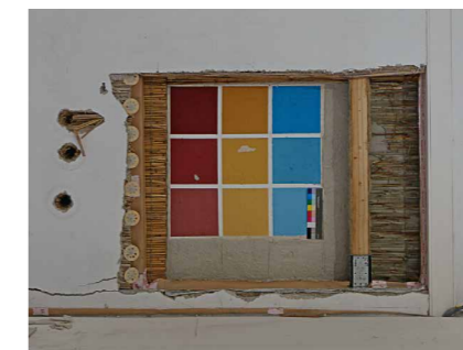
Abb. 3: Freilegung der Farbfelder nach zwei Jahren am Beispiel der Innendämmung mit Schilfrohr
