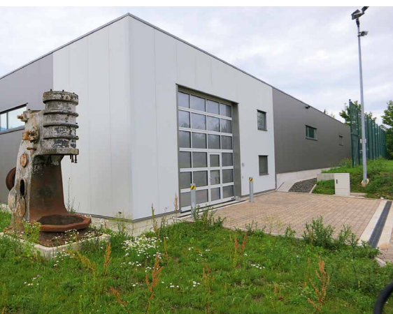
Abb. 1: Ansicht des Depots Kulturforum Schweinfurt als Beispiel für typische Depot-Neubauten
