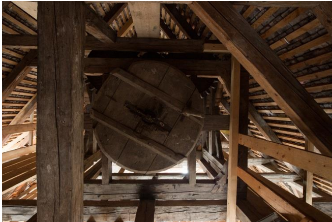
Der barocke Dachstuhl, datiert auf ca. 1760, mit einer historischen Aufzuganlage. © Fraunhofer IBP
