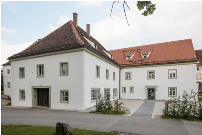
Die Alte Schäferei im sanierten Zustand. © Fraunhofer IBP
