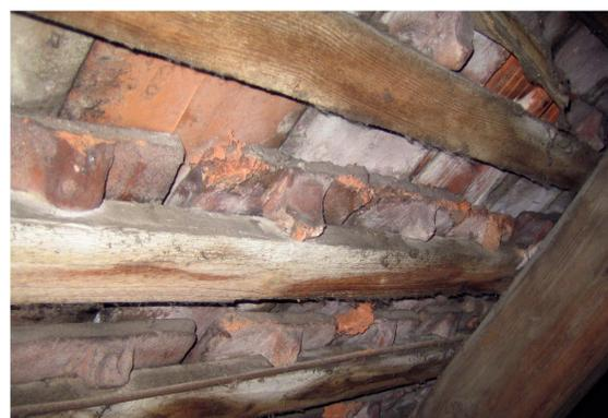
Am Kopf besitzt der Biberschwanz eine hakenförmige Erhebung, mit der er an der Dachlatte oder am nächsttieferen Ziegel eingehängt wird.
