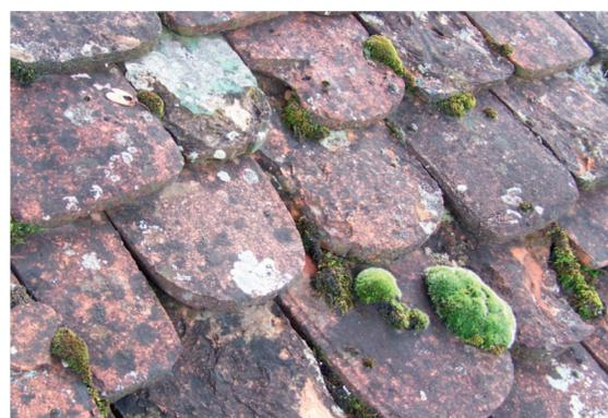
Die Dachziegel sind verschränkt aufgesetzt, so dass der höhere Ziegel jeweils um eine halbe Ziegelbreite versetzt ist. Dadurch wirkt das Doppeldach geschuppt.
