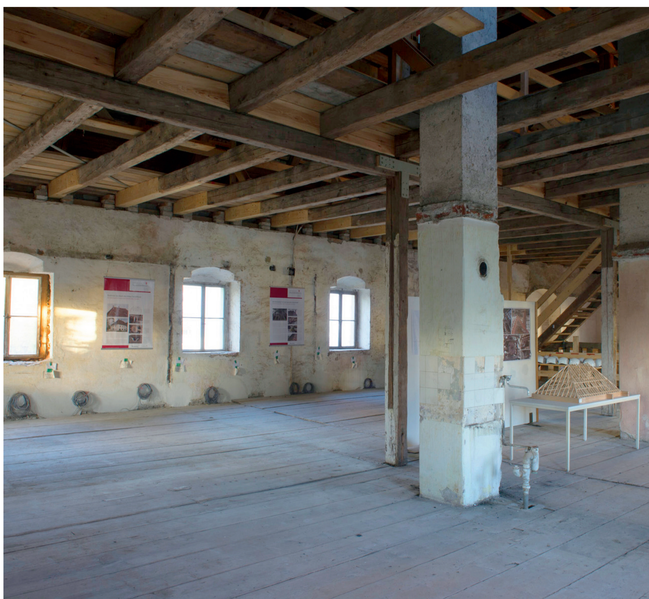
Obergeschoss der Alten Schafflerei vor Aufbringung der Innendämmung
