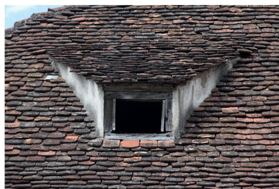
Schleppgauben sind als horizontale Belüftungsschlitze angelegt, um im Dachraum z.B. Güter zu trocknen. Sehr breite Schleppgauben werden auch als Dachhecht, Hechtgaube oder Hechtfenster bezeichnet.
