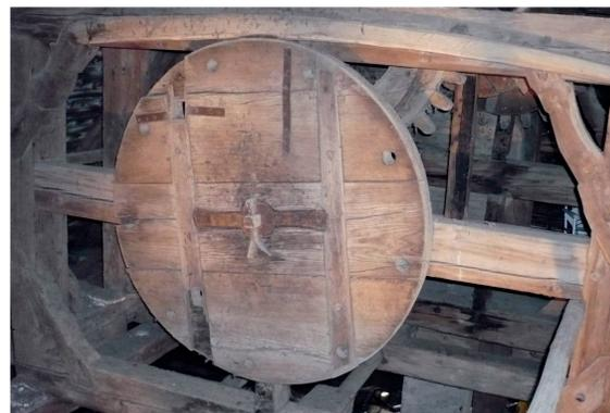
Materialien, die im Dachstuhl gelagert wurden, konnten mittels eines hölzernen Lastenaufzuges bewegt werden. Fehlende Abbundzeichen und eine Rötzeichnung weisen auf eine Zweitverwendung hin.
