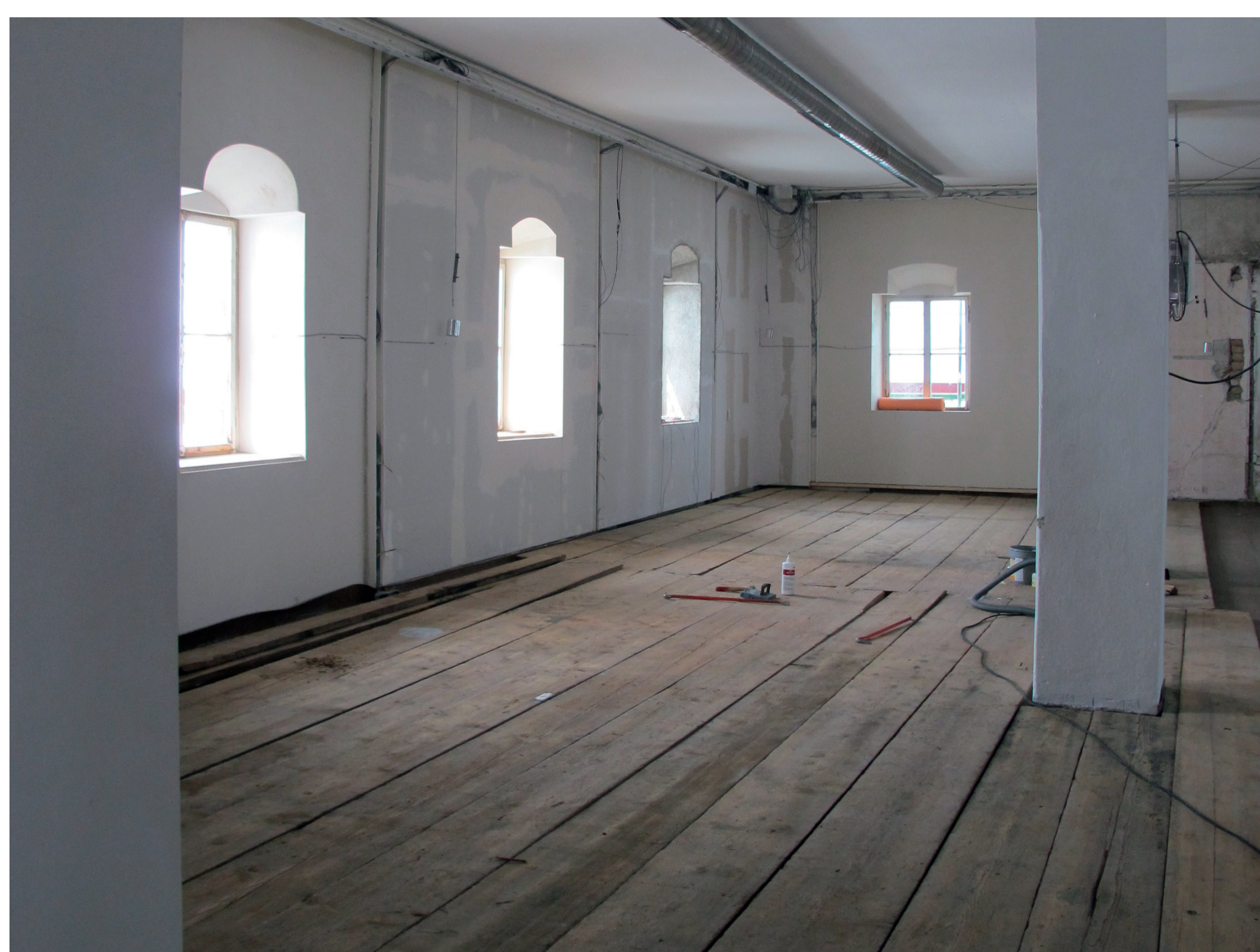
Originaler Holzdielenboden im Obergeschoss des Kopfbaus nach der Reparatur und Reinigung der Oberfläche
