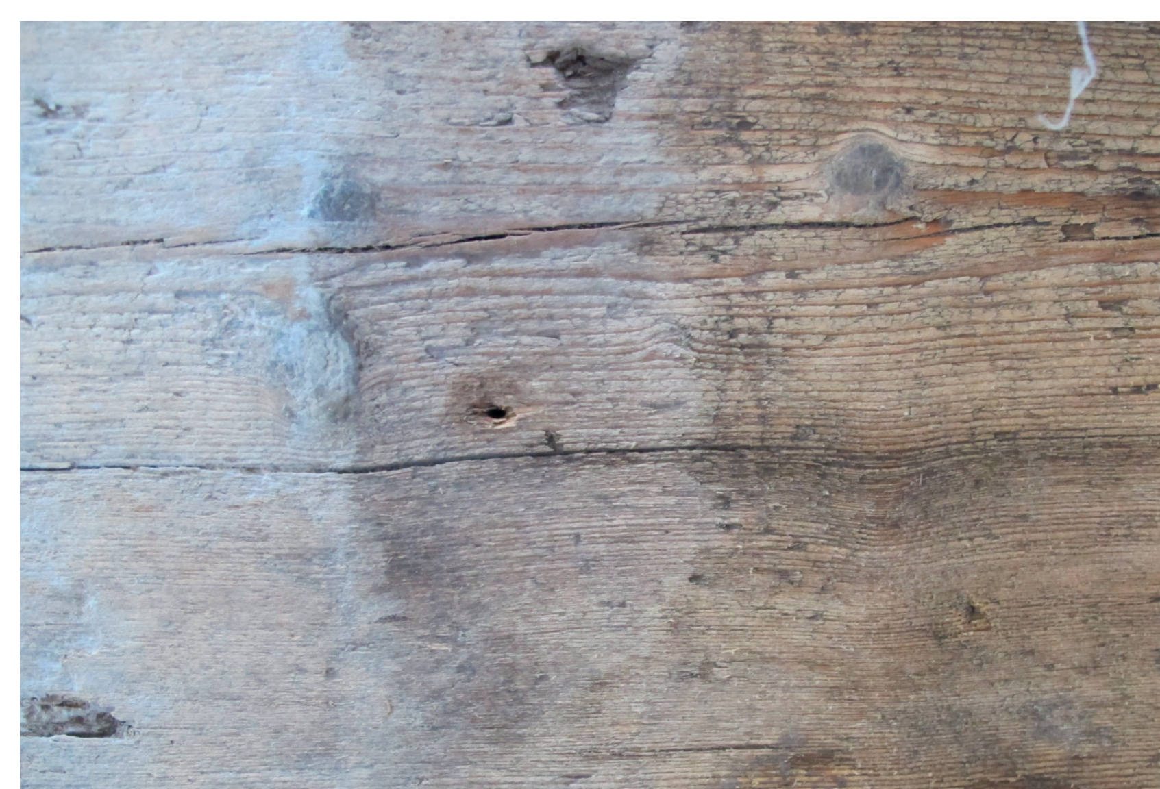
Originaler Holzdielenboden im Obergeschoss des Kopfbaus nach der Reparatur und Reinigung der Oberfläche
