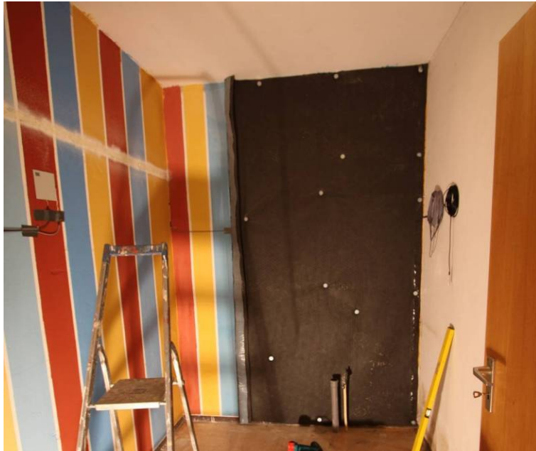
Bild 17: Messkonzept mit Anordnung der Sensoren und Messachsen im Versuchsgelände mit den Wänden Ost und Süd.
