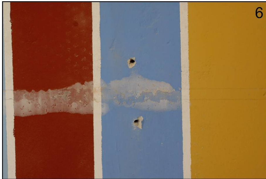
Bild 37: Detailbild 6 mit Resten von CCD der Abdichtung 3. An den Farbtönen des Bindemittelsystems Zellulose-Leims können keine Veränderungen erkannt werden.
