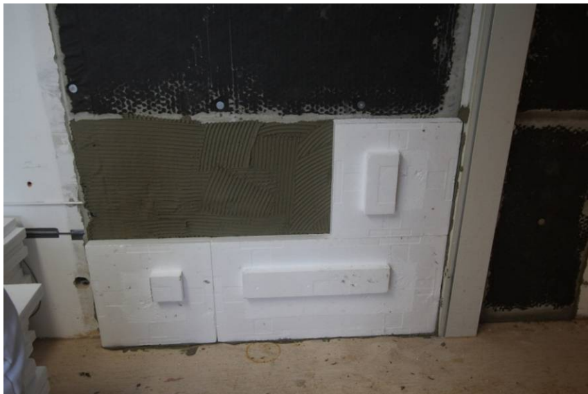
Bild 18: Anordnung der umlaufenden (grauer Fugenstreifen) Abdichtung mit Anarbeitung der unteren VIP Dämmplatte mit Klebemörtel bis zur ersten horizontalen Zwischenabdichtung bei der Wand Nord.
