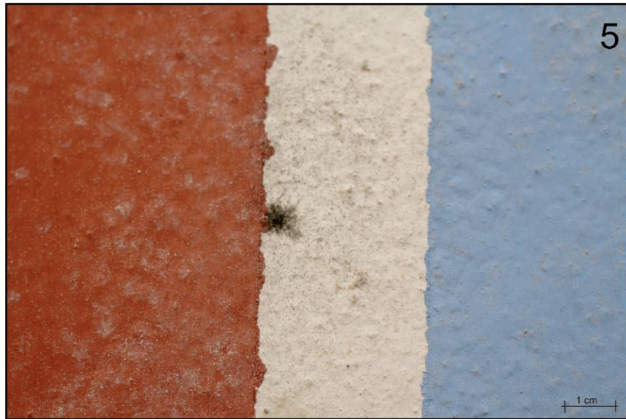
Bild 39: Detailaufnahme eines silikatischen Bindemittelsystems mit Schimmelpilz auf dem mit Innenwanddispersion gestrichenen Untergrund.
