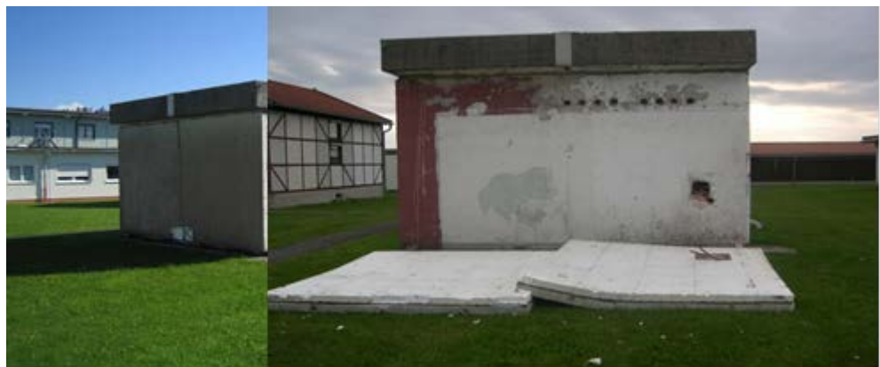
Bild 2: Für das Forschungsprojekt erforderliche Umbauarbeiten des bestehenden Versuchsgebäudes H-4 am Freigelände des Fraunhofer IBP, Rückbau einer vorhandenen Außendämmung.
