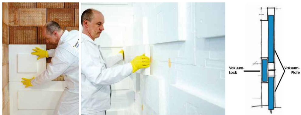
Bild 4: VIP für zweilagige Innendämmanwendung mit vollflächiger Verklebung und Polystyrol Kaschierung. Dieses System wurde zur Anwendung ausgewählt. Quelle: Weber-St.Gobain, Typ Lock-Plate.
