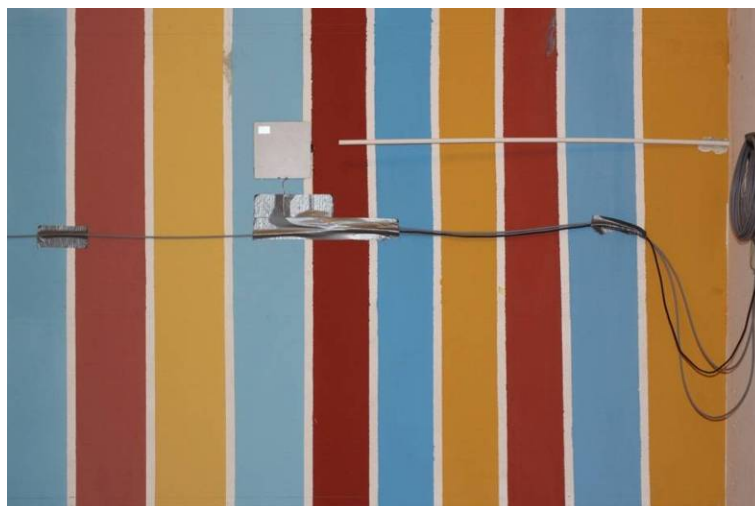
Bild 16: Ansicht der Südwand mit Farbanstrich und Messtechnik.
