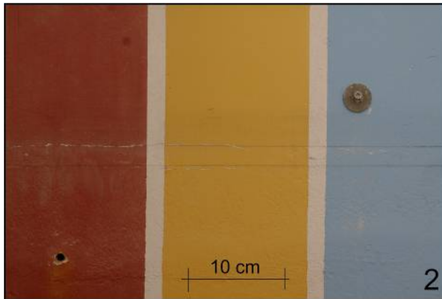
Bild 32: Wand Süd mit Detailansicht 2 in Höhe der Abdichtung 1 „Dichtband“. Es sind kaum Schäden vorhanden. Bei dem Ausschneiden des Wirrgeleges für die Herstellung der Dichtungsebene wurde die Oberfläche unabsichtlich geritzt.
