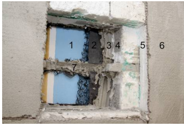
Bild 27: Bauteilöffnung der Innendämmung als Befundtreppe auf der Ostwand.
