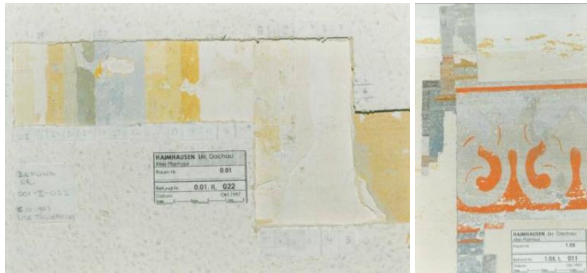
Bild 1: Freilegungstreppe historischer Farbfassungen in einem Pfarrhaus aus dem 16. Jahrhundert in Haimhausen nahe München (Foto: Klaus Klarner, Restaurator, München).
