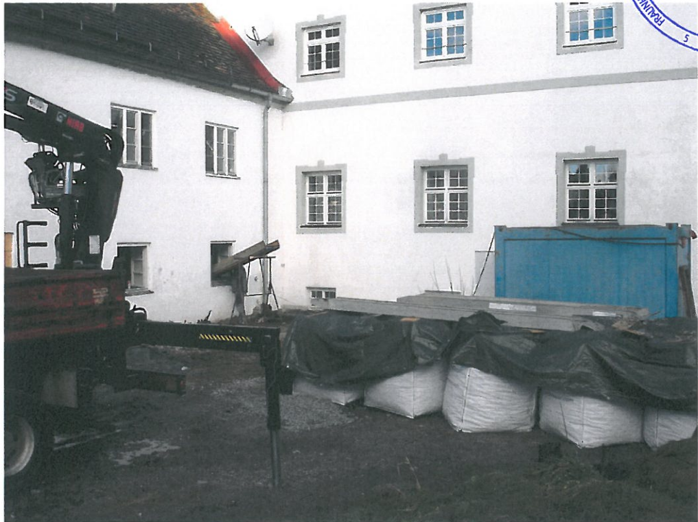
Bild 3: Technopor Bigbags; LKW mit Kran und Schütte zum Einbringen des Granulates über die Fenster.
