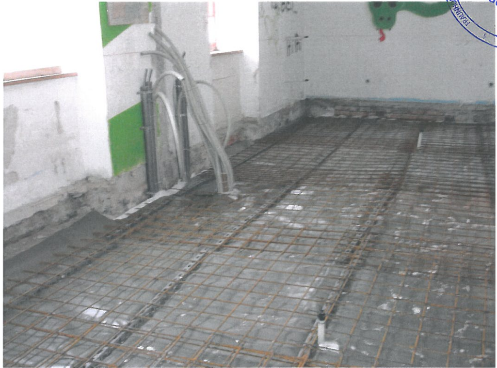
Bild 10: Einbringen der Stahlarmierung der Bodenplatte.
