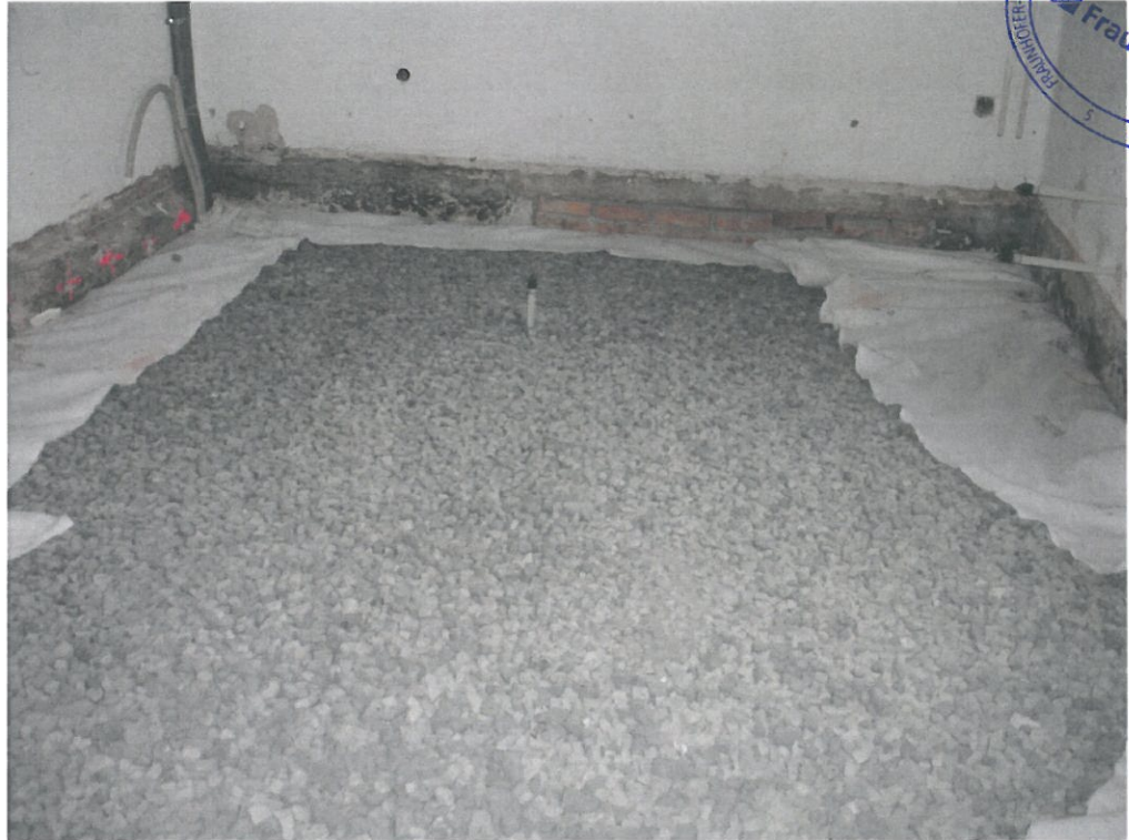
Bild 7: Einschlagen des überstehenden Geotextils nach Verdichtung der zweiten Lage.
