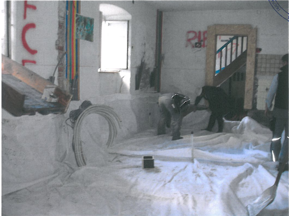
Bild 4: Einbringen des Geotextils.
