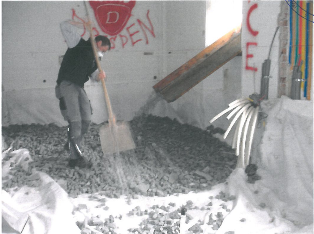
Bild 5: Einbringen des Granulates.
