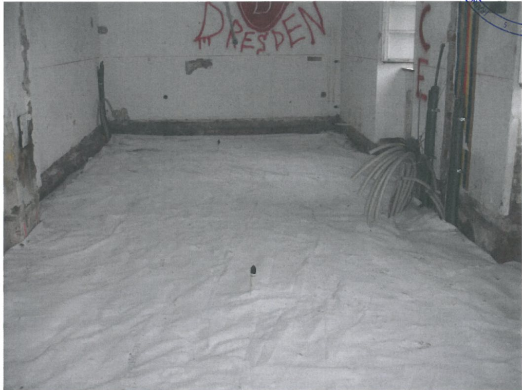
Bild 8: Komplette Abdeckung mit Geotextil.
