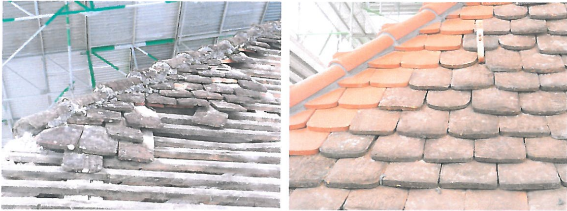
Bild 10 (links): Vorzustand eines Dachgrates mit originalem Ziegelbestand.
