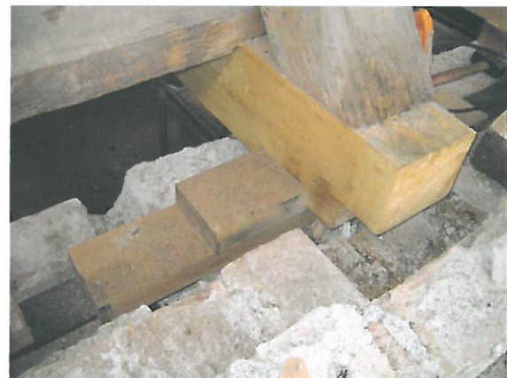
Bild 5 (rechts): Gesund geschnittenes Holz, Reparatur des Fußpunktes mittels Überblattung.
