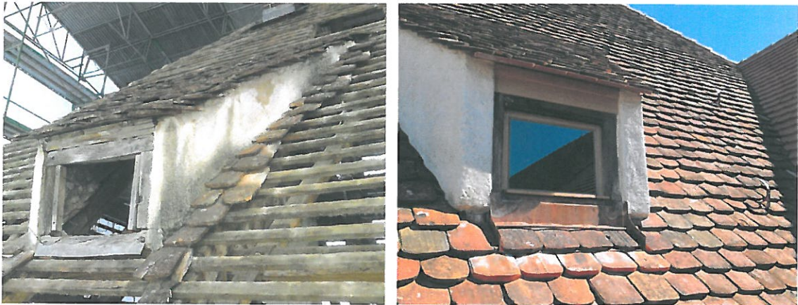
Bild 8 (links): bauzeitliche SchlepPGAube im Süden der Alten Schäfllerei.
