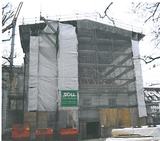
Bild 2: Einhausung des Kopf- und Nordbaus der Alten Schäferei als Witterungsschutz für das barocke Dachwerk während der gesamten Dachinstandsetzung.
