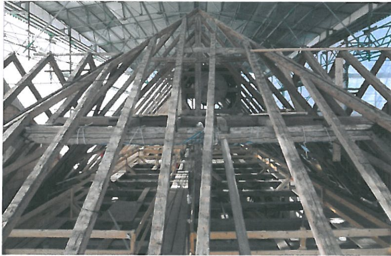
Bild 3: Dachwerk des Kopfbaus unter der Schutzeinhausung, Foto: Uwe Gaasch.
