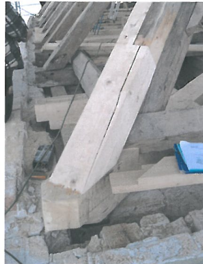
Bild 4 (links): Fäulnisschäden am Fußpunkt des westlichen Gratsparrens und der Mauerlatte.
