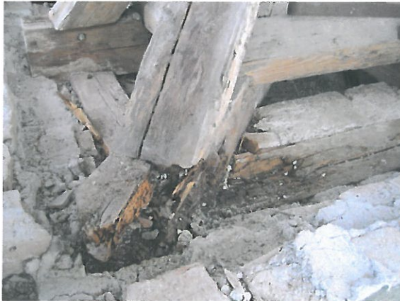
Bild 4 (links): Fäulnisschäden am Fußpunkt des westlichen Gratsparrens und der Mauerlatte.
