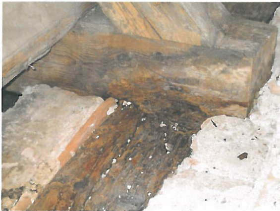
Bild 6 (links): Schäden an eingemauerter Mauerlatte.
