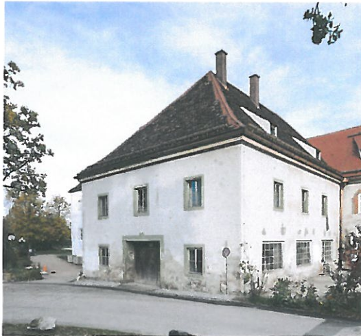
Bild 1: Westansicht der Alten Schäferei nach Abschluss des ersten Bauabschnittes mit Instandgesetztem Dach.
