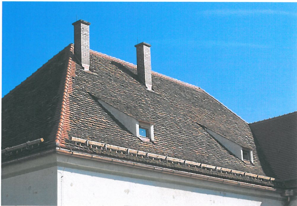
Bild 12: Instandgesetztes des Dachwerk mit Wiedereindeckung der originalen Ziegel.
