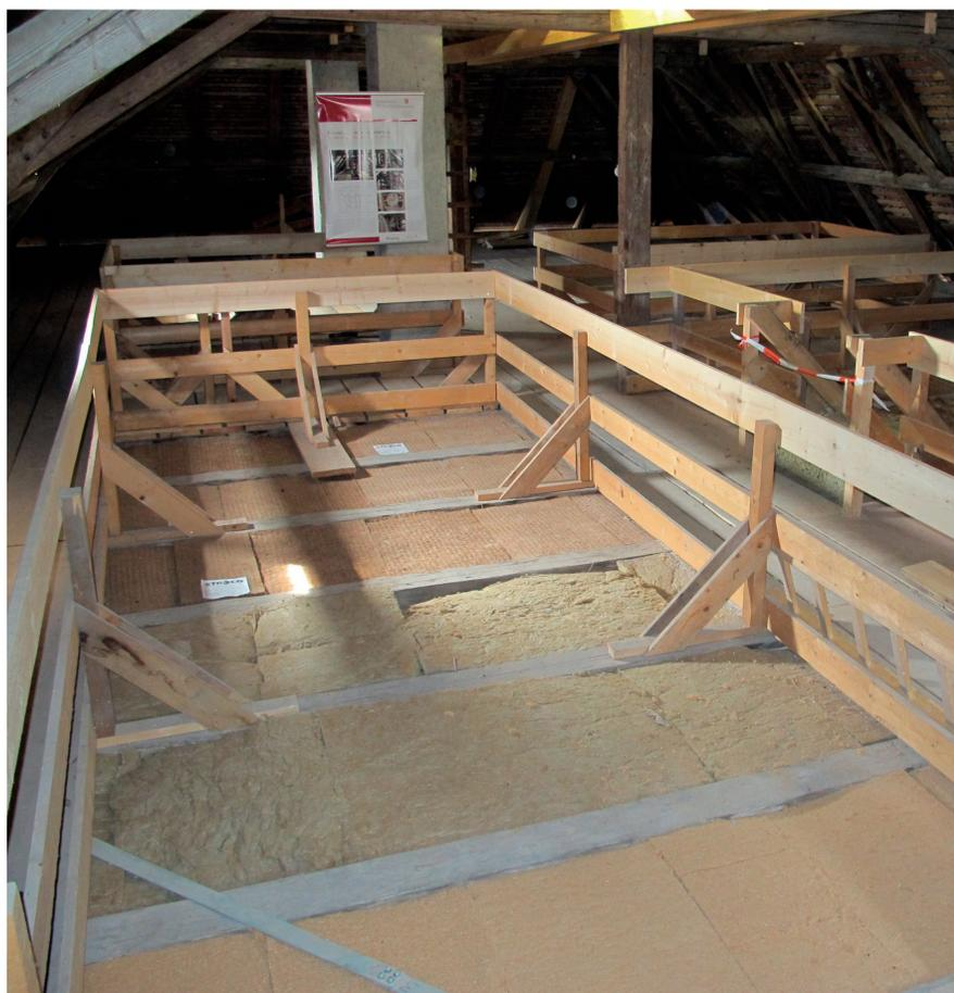
Einbau der verschiedenen Dämmmaterialien in der obersten Geschossdecke des Kopfbaus
