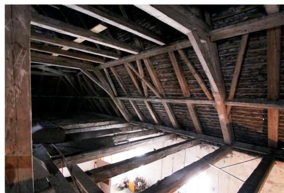
Um das barocke Dachwerk weiterhin für die Besucher des Fraunhofer-Zentrums Benediktbeuern sichtbar und einsehbar zu belassen, wurde die Dachfläche des Kopfbaus der Alten Schäfllerei nicht gedämmt und funktioniert als hinterlüftetes Dach.
