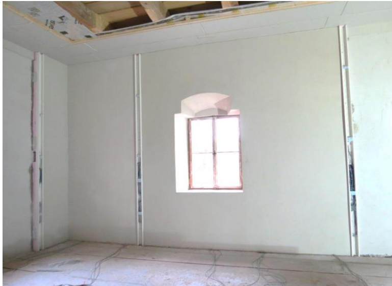
Bild 70: Feld 12 und 13 (Wandabschnitt neben dem linken Fenster und rechte Wand) mit eingebettetem Glasfasergewebe im Grundputz, fertiger Zustand, Oktober 2013.
