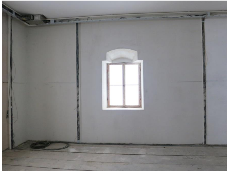
Bild 110: Fertig erstellte Innendämmung mit Oberflächen-Temperatursensoren, Aufnahme vom 9. Februar 2015.
