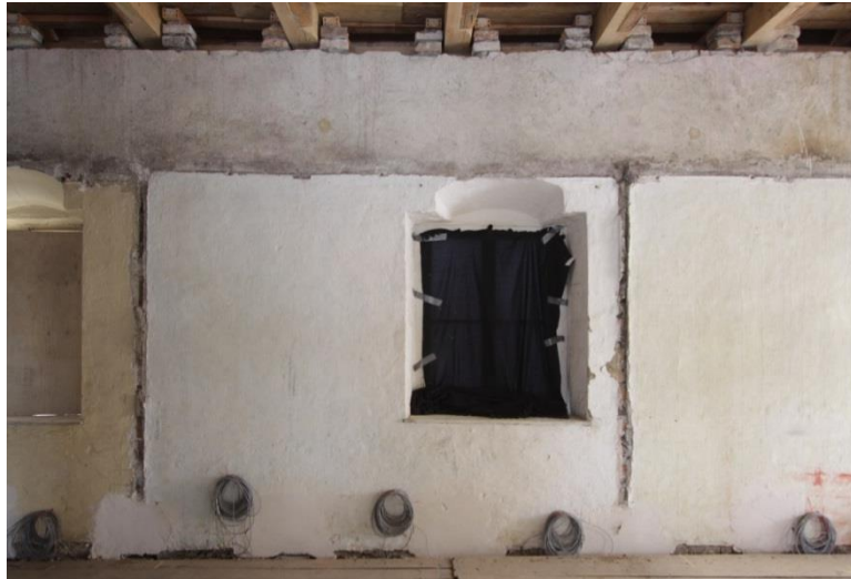
Bild 71: Feld 6 vor der restauratorischen Aufbereitung der Oberfläche und Instandsetzung des Mauerwerks, Aufnahme am 18.3.2013.
