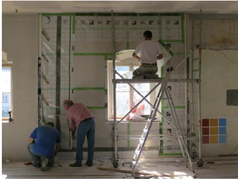
Bild 82: Wandfeld 6 mit vorgebauten Gipskartonbauplatten, Oktober 2014.
