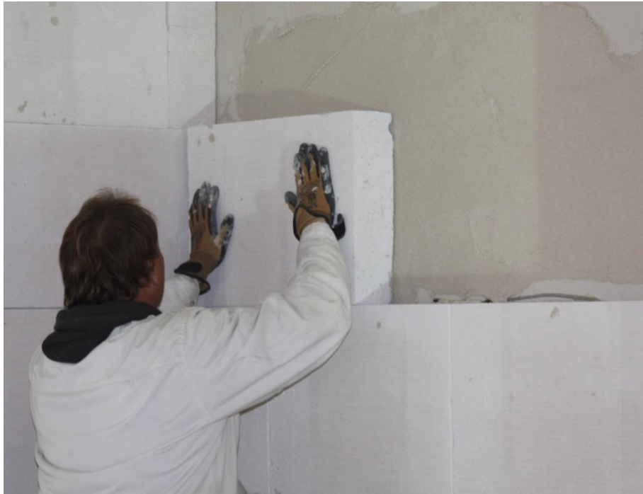
Bild 22: Verputzte Mineraldämmplatte zur Innendämmung einer Außenwand.
