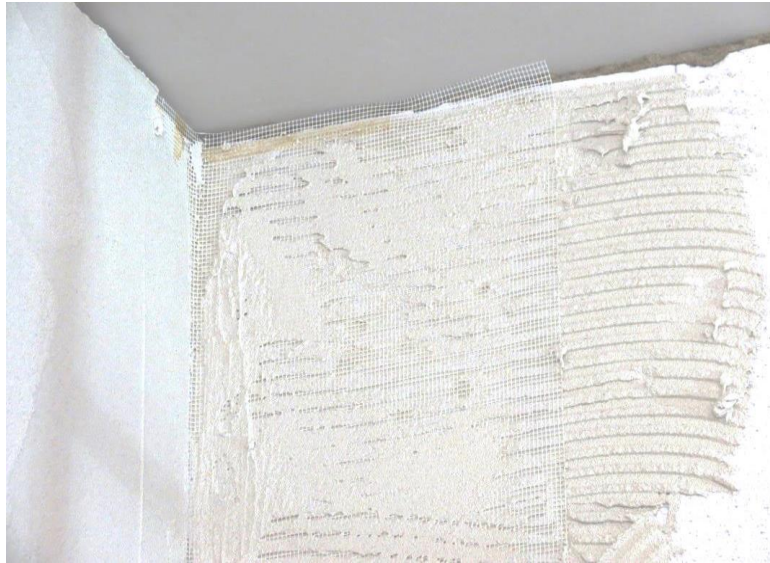
Bild 68: Glasfaserdichtungsgewebe auf den Leichtputz aufgezogen und eingebettet, Oktober 2013.
