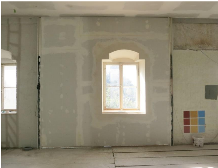
Bild 74: Feld 6 mit Innendämmung und fertig verspachtelter Trockenbauplatte der Innendämmkonstruktion, Aufnahme am 16.10.2014.
