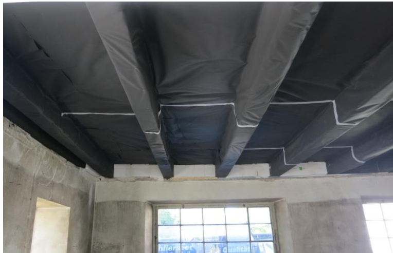
Bild 31: Ansicht der Geschossdecke von unten (EG) mit Rieselschutzflies und noch ohne Zwischendämmung.
