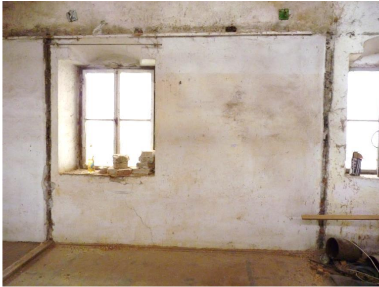
Bild 55: Feld 13 während der ersten Bauphase nach Rückbau der Innenwände der Flüchtlingseinbauten der 1940 / 50er Jahre, Aufnahme am 11.11.2011.
