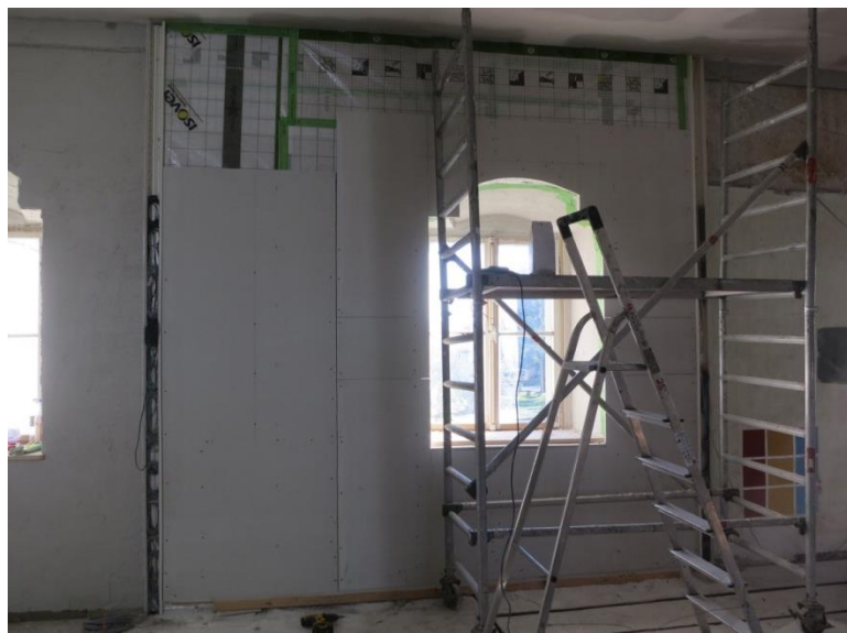
Bild 83: Gipsfaserplatten als raumseitiger Abschluss, Oktober 2014.
