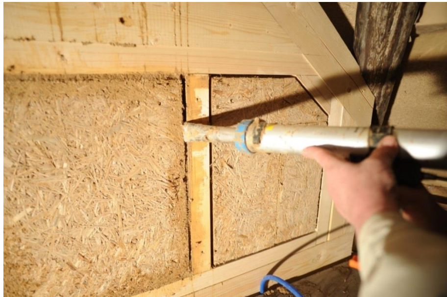
Bild 18: Typha-Dämmplatten und Typha-Fugenmörtel zur winddichten Dämmung der Wandausfachung.
