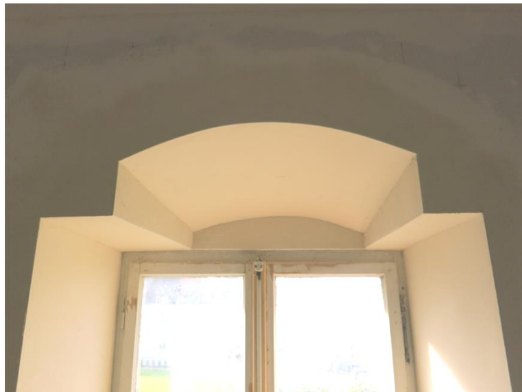
Bild 88: Abschließender Gipsputz in der Fensterlaibung, Oktober 2014.
