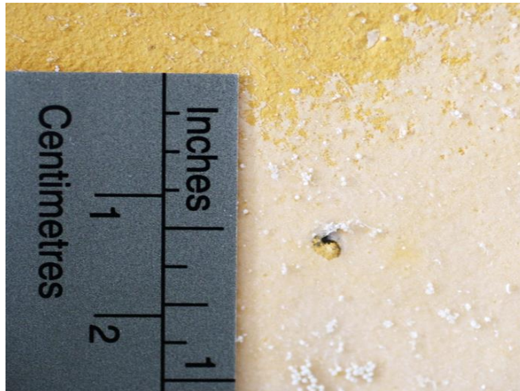
Bild 176: Detail, Farbmatrix nach partiellem Rückbau der Innendämmung mit Resten des Cyclododecans und des Latexmörtels.
