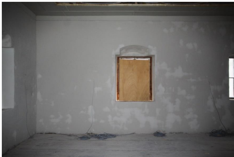
Bild 58: Feld 13 mit reversibler Putzschicht und fertigen Anschlüssen zur oberen Geschossdecke, Aufnahme am 30.09.2013.
