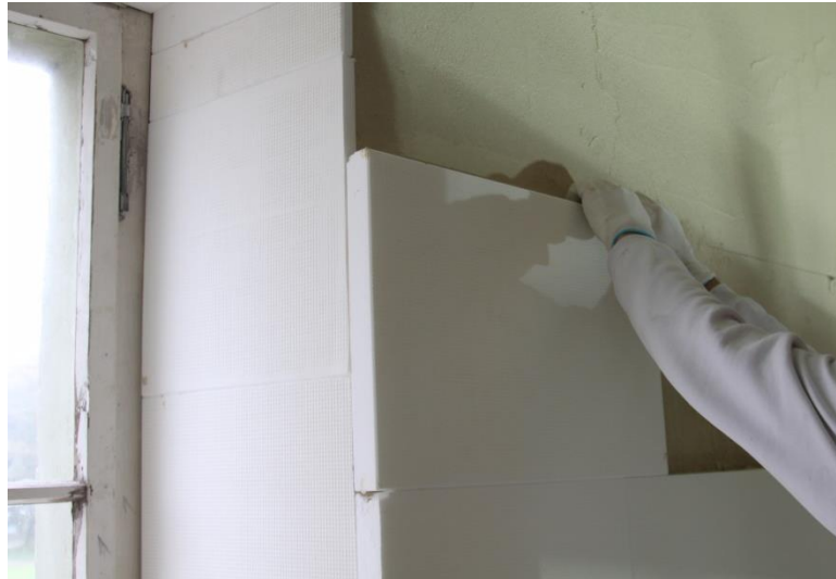
Bild 28: Aufbringen von Aerogeldämmplatten an einer Außenwand mit Fensterlaibung.
