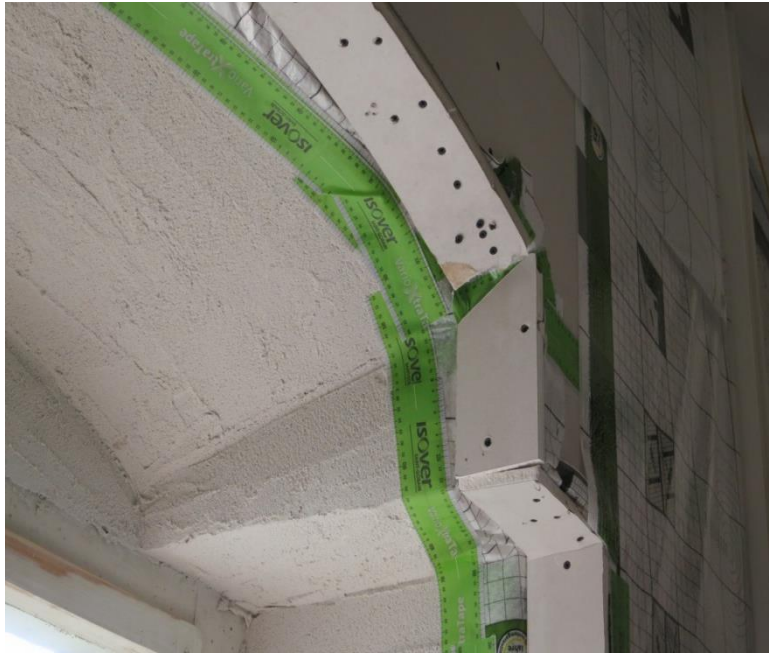
Bild 84: Laibung mit Vlies und Band abgedichtet und mit Gipsfaserplatten-Streifen abgeschlossen, Oktober 2014.
