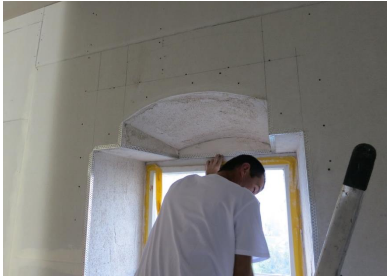
Bild 85: Fläche des Wandfeldes 6 verkleidet mit Gipsfaserplatten und Fensterlaibung mit Wärmedämmputz verputzt, Oktober 2014.
