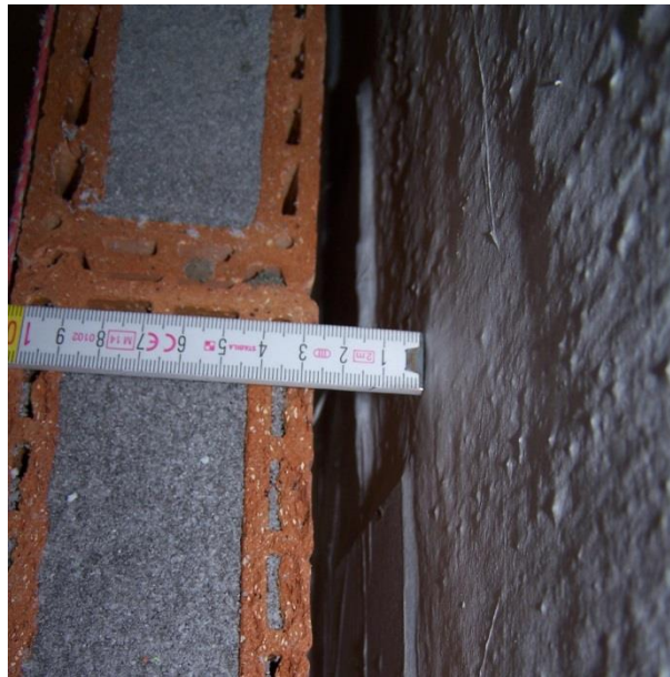
Bild 25: Vormauerziegel mit Perlite-Füllung zur Innendämmung von Wänden.
