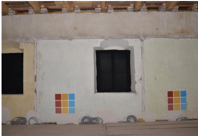
Bild 72: Feld 6 mit Testfarbfelder zur Überprüfung der Reversibilität und erster Sensorik, Aufnahme am 16.09.2013.
