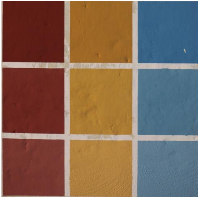
Bild 182: Farbmatrix vor Einbau der Innendämmung, Feld 6.
