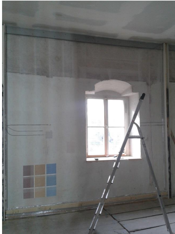
Bild 79: Oberfläche des Wandfeld 6, kaschiert mit Japanpapier, Oktober 2014.
