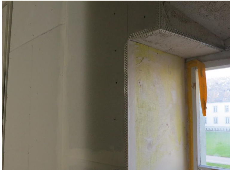
Bild 87: Fensterlaibung ausgekleidet mit Glasfasergewebe, Oktober 2014.
