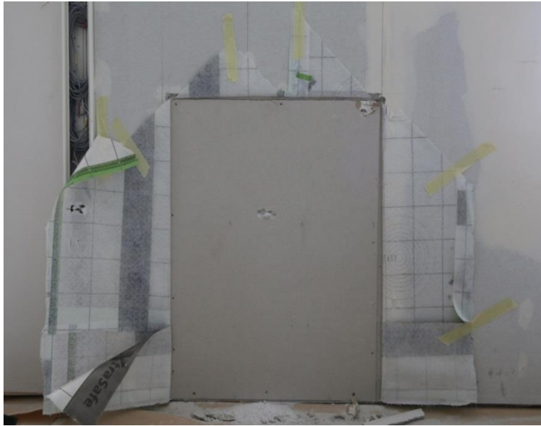
Bild 178: Partielle Versuchsfeldöffnung, nach Entfernen der Gipskartonplatte, Feld 6.
