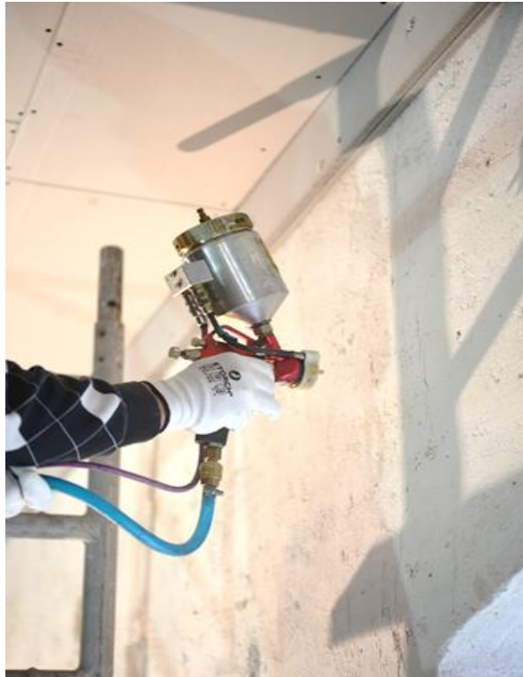
Bild 165: Auftrag Cyclododecan als Schmelze mit einer beheizten Sprühpistole und Luftdruck.
