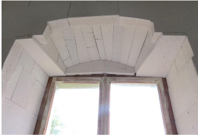
Bild 66: Fensterlaibung von Feld 13 verkleidet mit Laibungsplatten, Oktober 2013.
