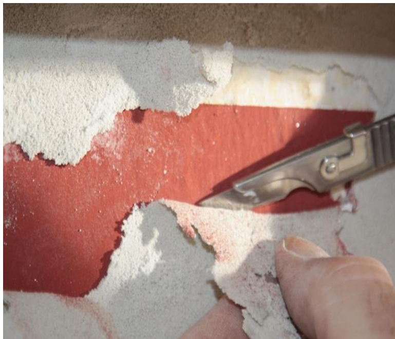
Bild 172: Restauratorische Abnahme des Latex-Leichtmörtels mit dem Skalpell, am Feld 13.01.
