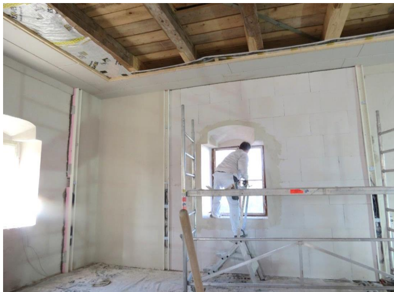
Bild 69: Glasfaserdichtungsgewebe auf Dämmplatten mit Leichtputz verputzt, Oktober 2013.
