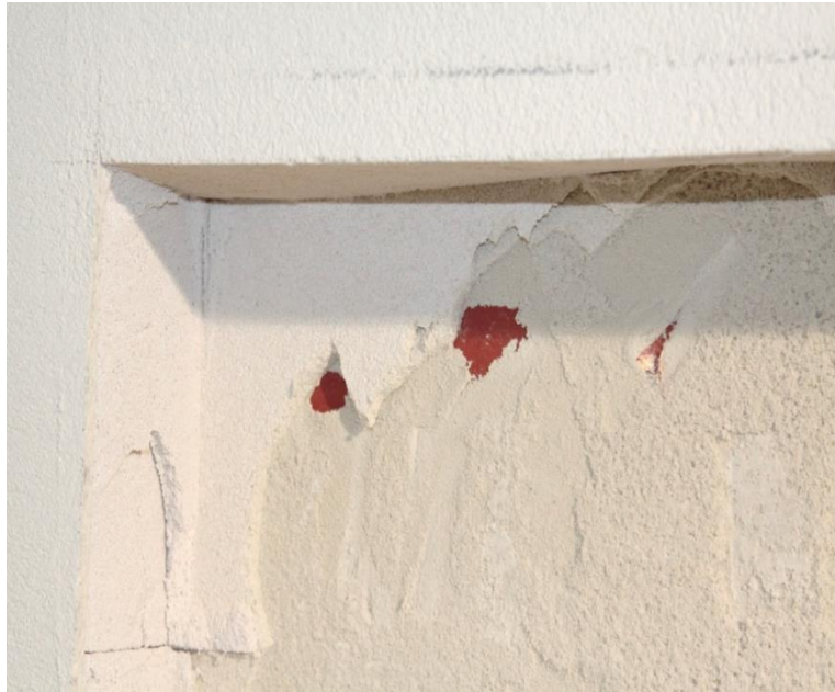
Bild 171: Partielle Versuchsfeldöffnung, Feld 13. Unter dem Dämmstoff wird der reversible Mörtel sichtbar und erste Bereiche der verdeckten Farbfassung / Farmatrix.
