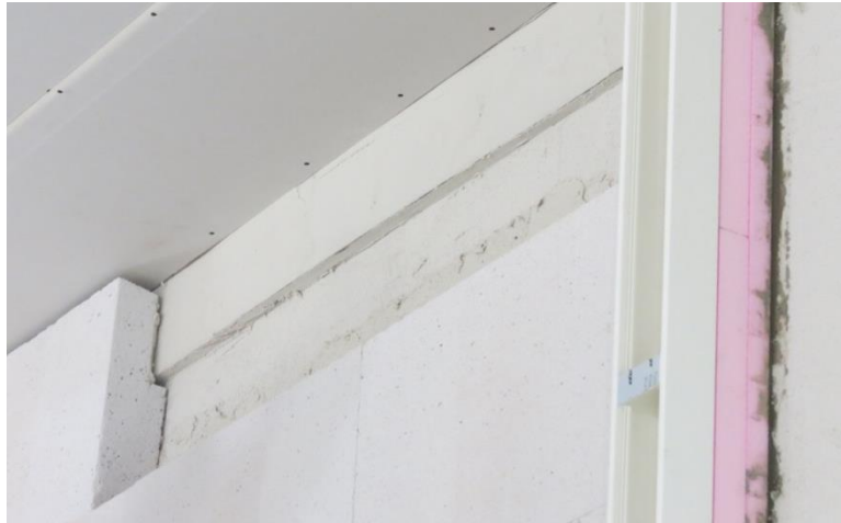
Bild 64: Feld 13 mit zurechtgeschnittenen Mineraldämmplatten, Oktober 2013.
