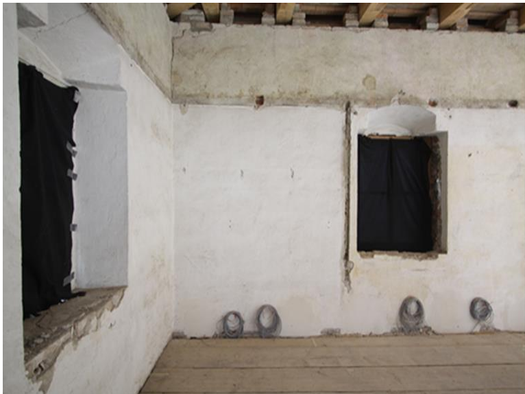
Bild 56: Feld 12 und 13 (Wandabschnitt neben dem linken Fenster und rechte Wand) vor dem Einbau der Innendämmung, 18.3.2013.
