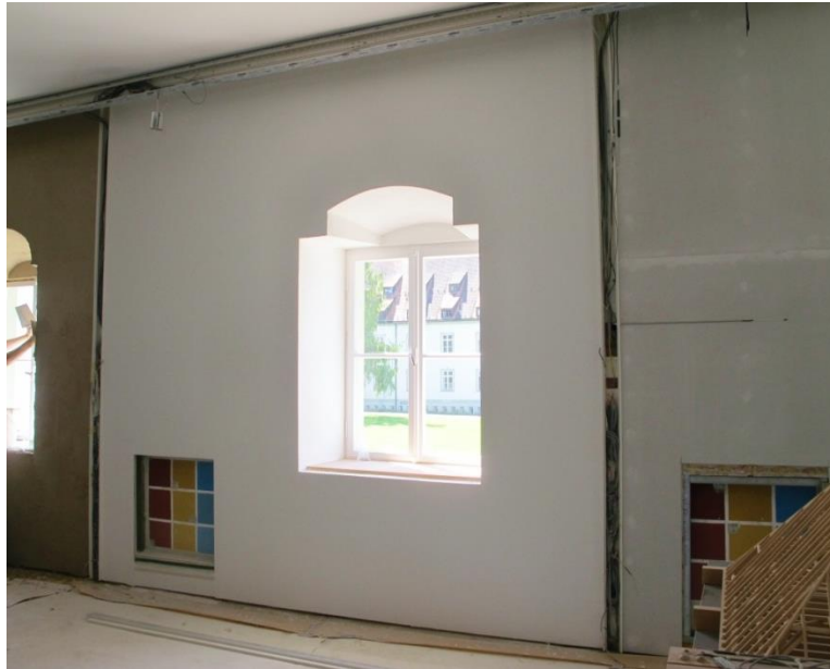
Bild 75: Feld 6 mit Innendämmung und partieller Freilegung der Farbmatrix, Aufnahme am 19.07.2016.
