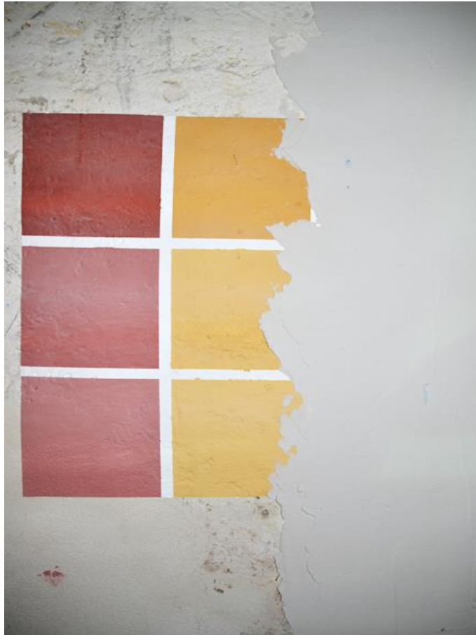
Bild 167: Auftrag des Latex-Leichtmörtels.
