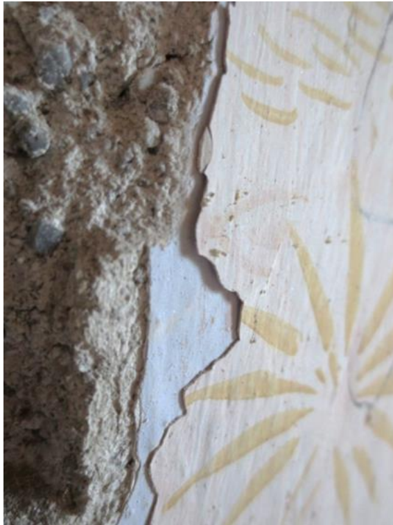
Bild 12: Schichtenaufbau, exemplarisch Feld 08.
