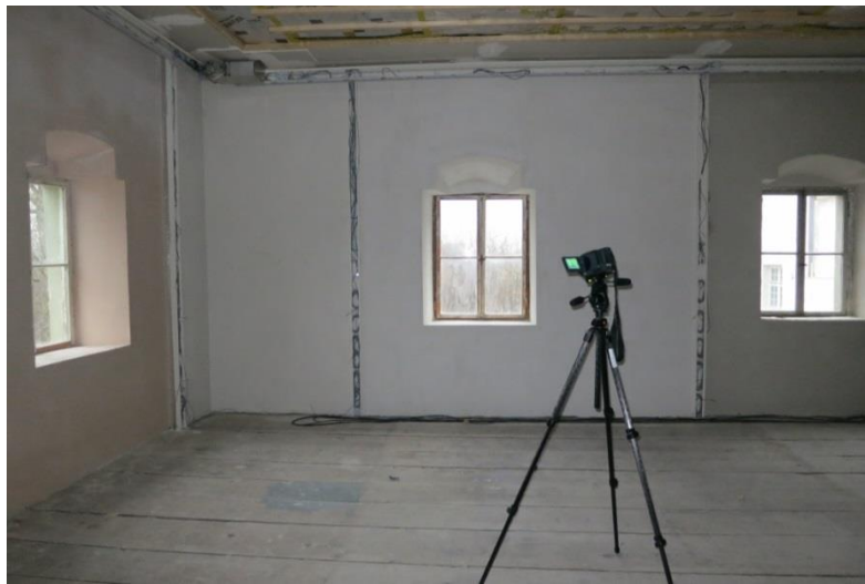
Bild 108: Fertig erstellte Innendämmung mit IR-Kamera im Vordergrund, Aufnahme vom 4. März 2014.
