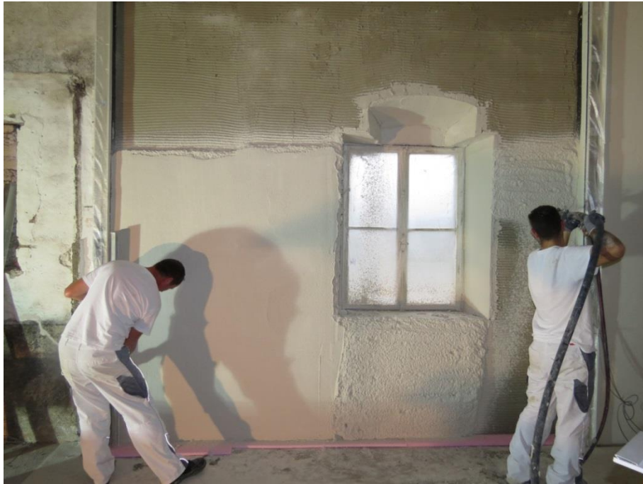
Bild 27: Maschinelle Applikation von Aerogel-Wärmedämmputz auf einer Außenwand.
