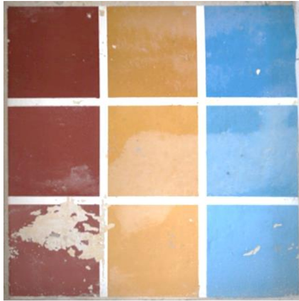
Bild 174: Farbmatrix nach partiellem Rückbau der Innendämmung, Feld 13
