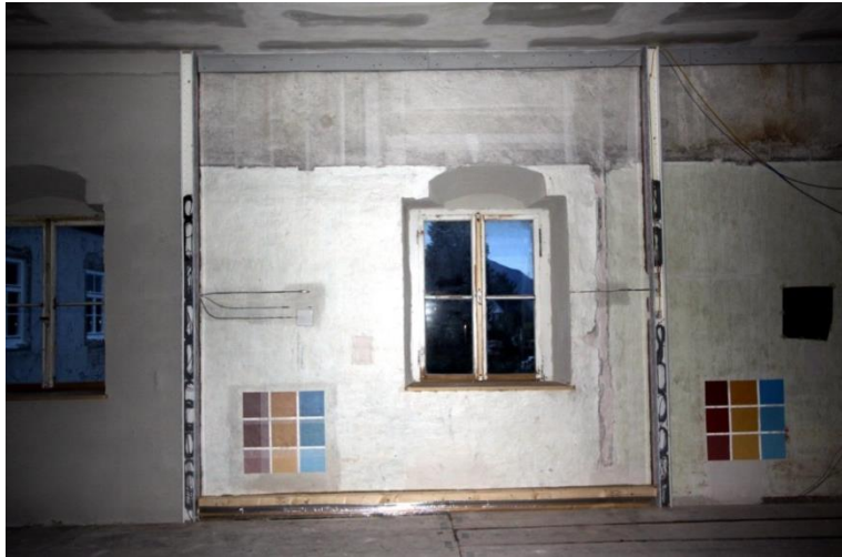
Bild 73: Feld 6 mit fertig montierten Sensoren und vollflächig aufgebrachter Kaschierung mit Japanpapier, Aufnahme am 7.10.2014.
