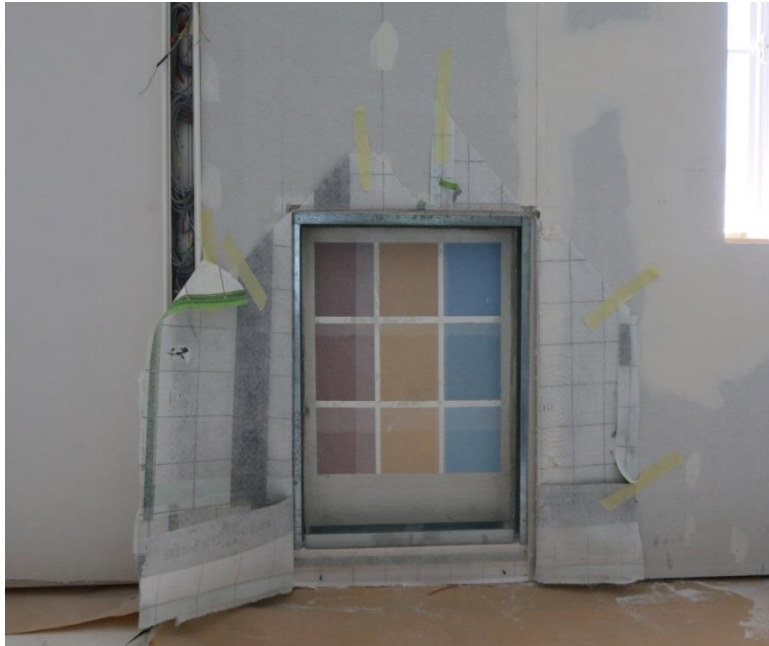
Bild 180: Partielle Versuchsfeldöffnung nach Entnahme des Dämmstoffs, vor Abnahme des Japanpapiers, Feld 6.
