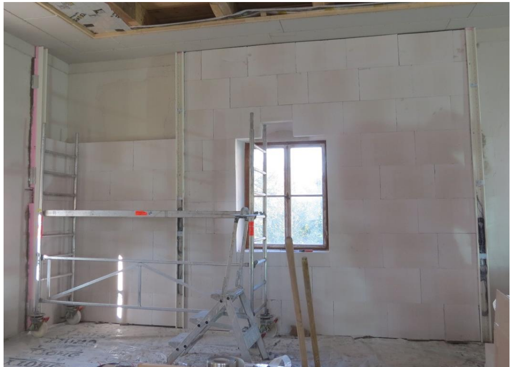
Bild 63: Feld 12 und 13 (Wandabschnitt neben dem linken Fenster und rechte Wand) mit reversibler Putzschicht und darüber liegenden Mineralfüllplatten, Oktober 2013.
