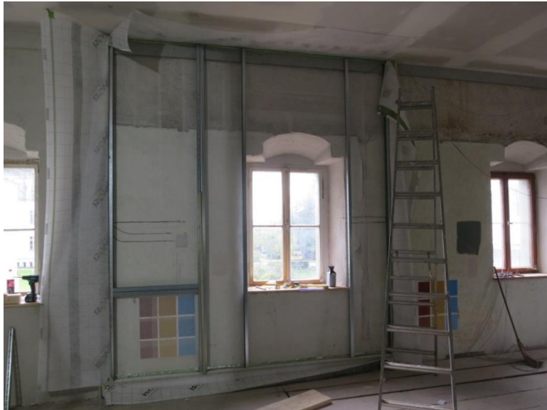
Bild 80: Rahmengestell für die vorgeständerte Innendämmkonstruktion aus Perlite-Schüttung, Oktober 2014.
