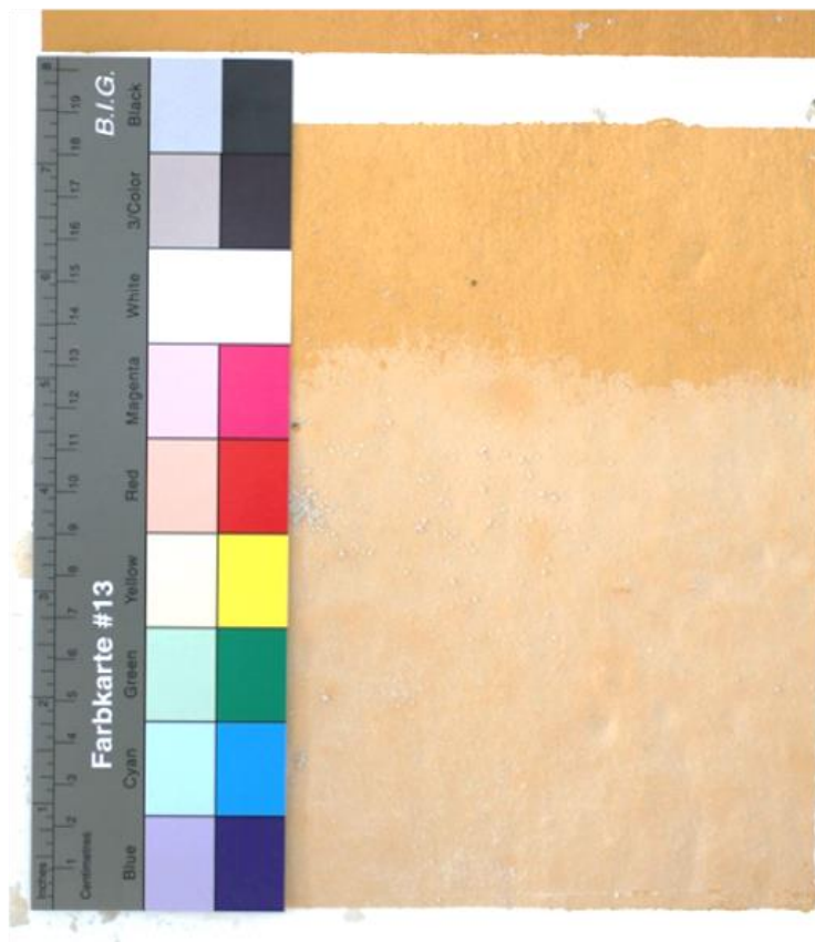
Bild 175: Detail, Farbmatrix nach partiellem Rückbau der Innendämmung mit Weiß-
