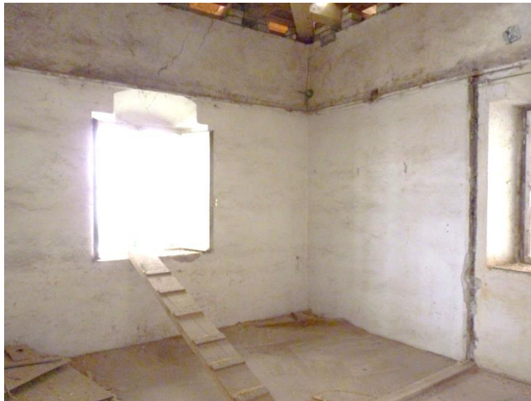
Bild 54: Feld 12 (Eckfeld) während der ersten Bauphase nach partiellem Rückbau der Innenwände der Flüchtlingseinbauten der 1940 / 50er Jahre, Aufnahme am 11.11.2011.
