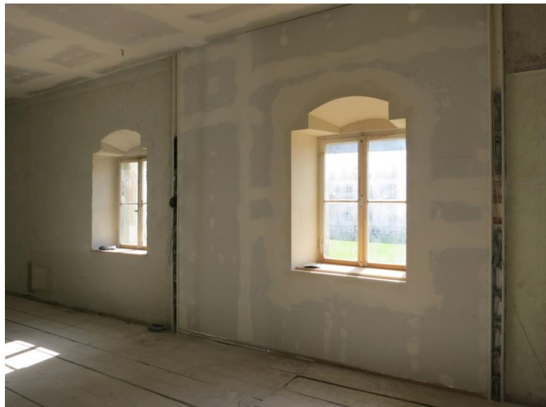
Bild 86: Fugen der Gipsfaserplatten mit Gipsspachtelmasse verspachtelt, Oktober 2014.
