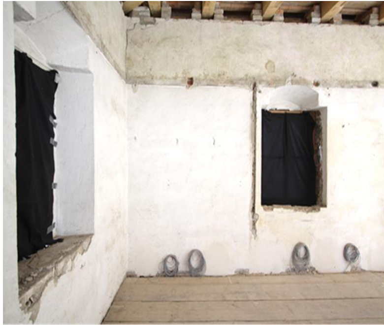
Bild 168: Feld 12 und 13 (Wandabschnitt neben dem linken Fenster und rechte Wand) vor dem Einbau der Innendämmung, Oktober 2013.
