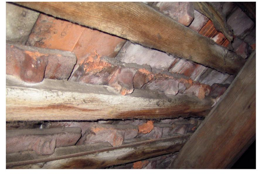
Am Kopf besitzt der Biberschwanz eine hakenförmige Erhebung, mit der er an der Dachlatte oder am nächsttieferen Ziegel eingehängt wird.
