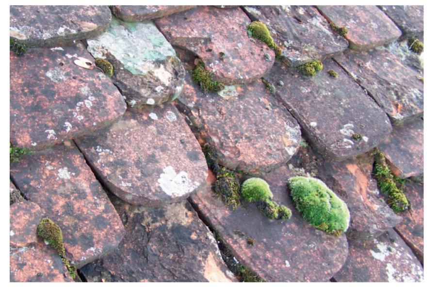
Die Dachziegel sind verschränkt aufgesetzt, so dass der höhere Ziegel jeweils um eine halbe Ziegelbreite versetzt ist. Dadurch wirkt das Doppeldach geschuppt.
