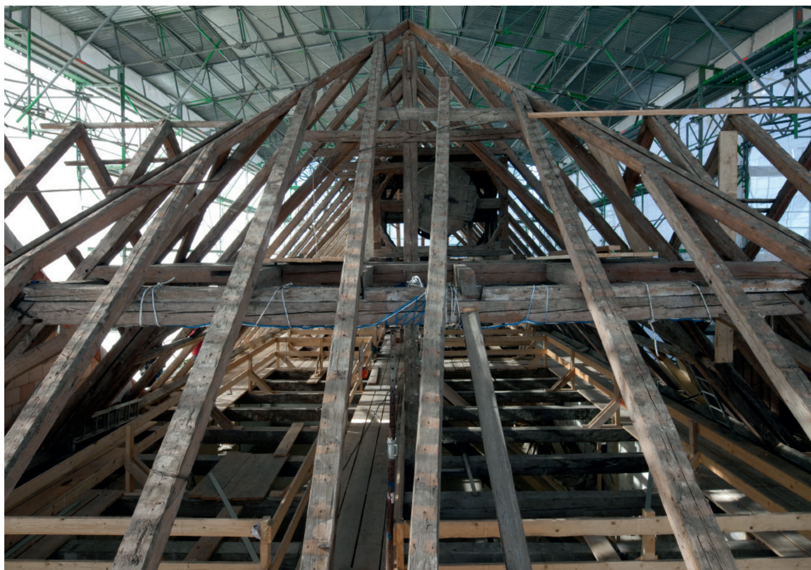
Barockes Dachwerk des Kopfbaus der Alten Schäferei unter einer Schutzzeinhäusung, Foto: Uwe Gaasch
