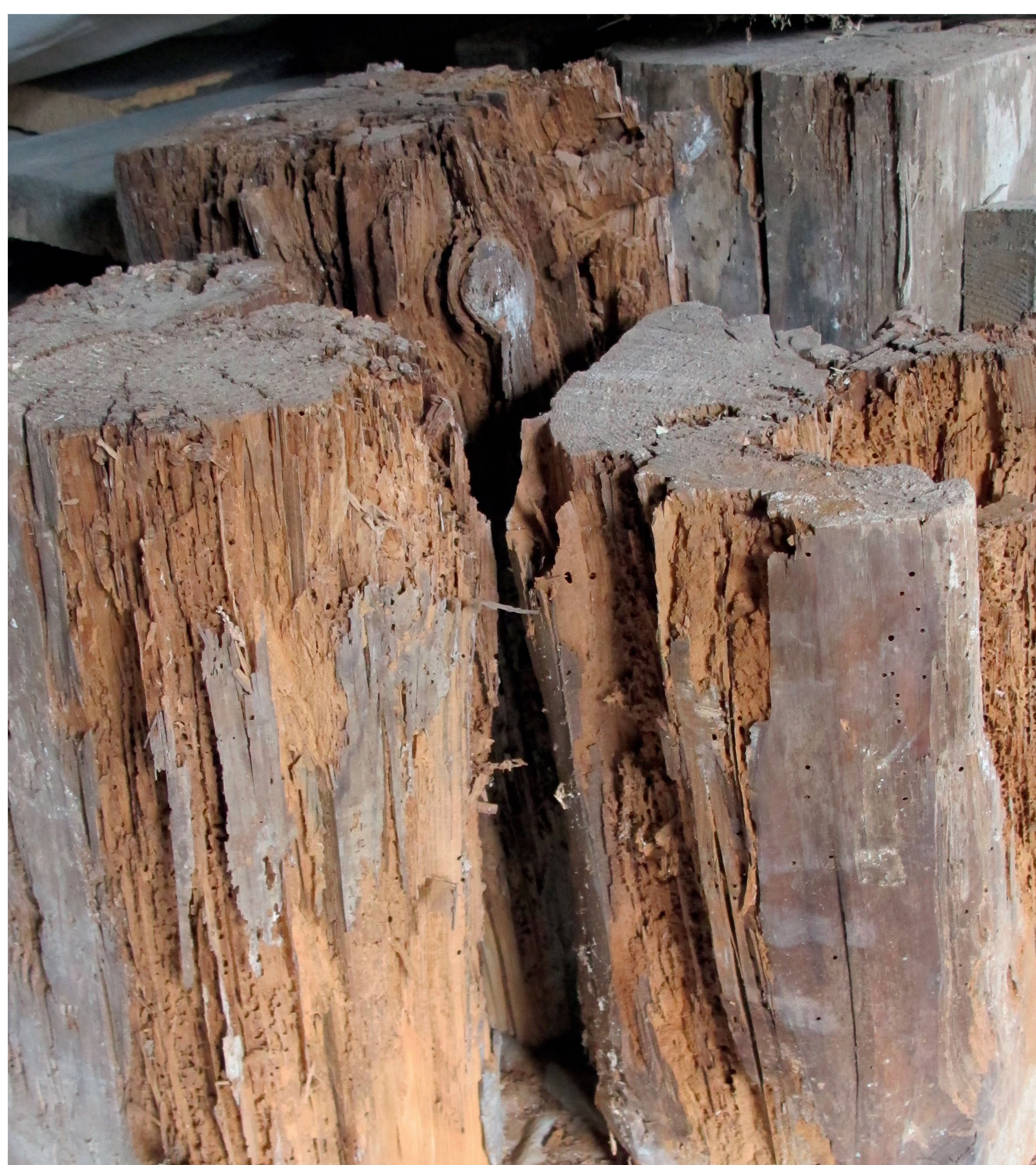
Schadhafte Balkenköpfe der Alten Schöfflerei
