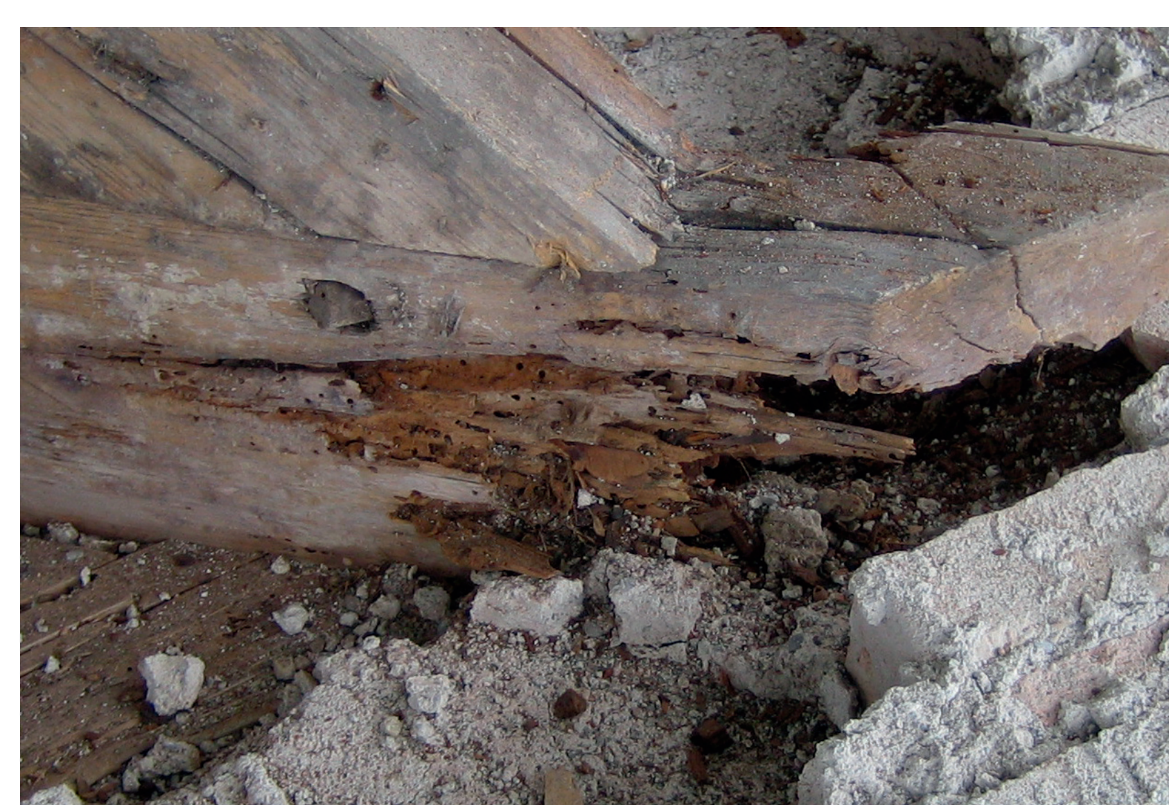
Schadhafte Balkenköpfe der Alten Schöfflerei
