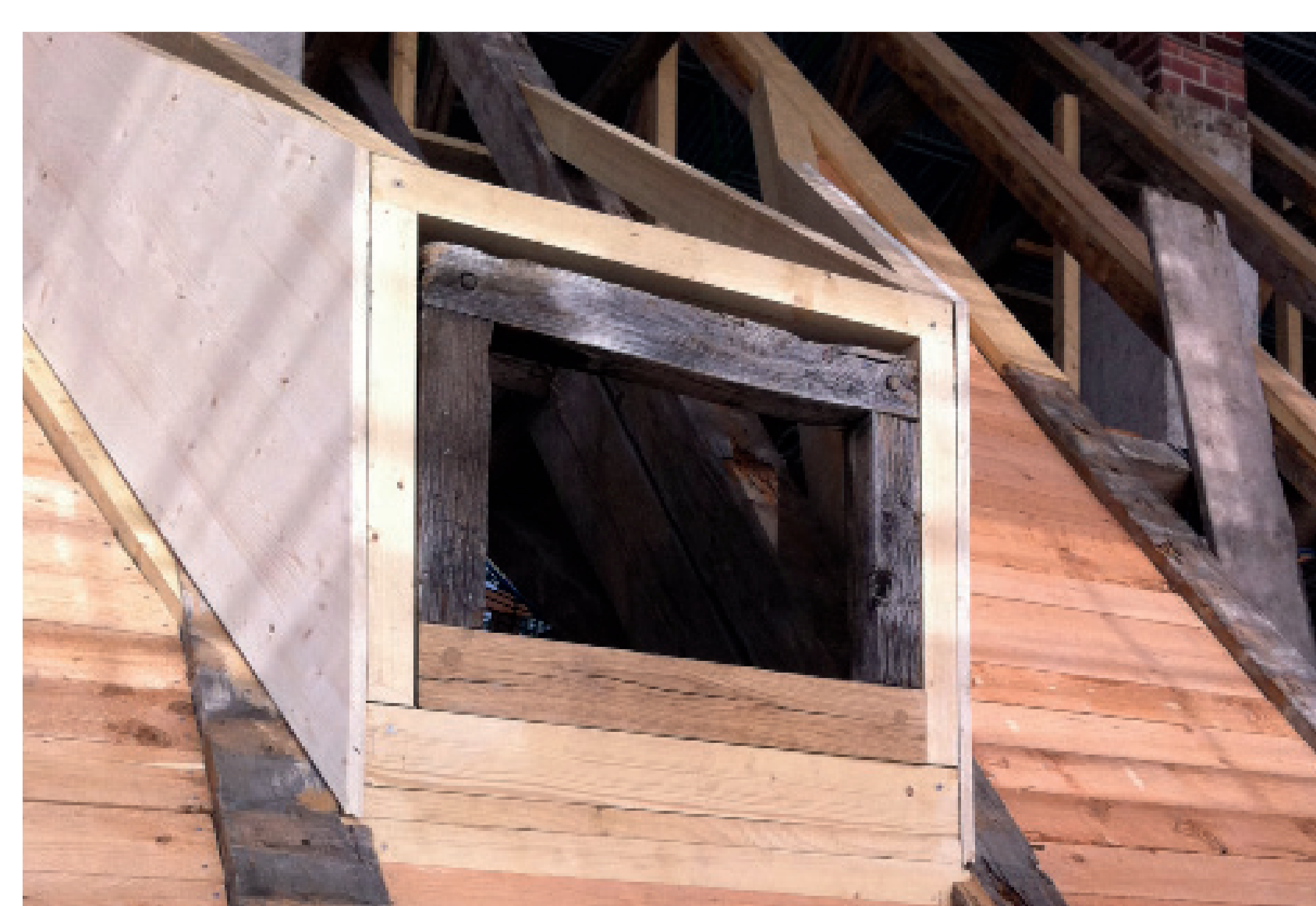
Die Wiederverwendung des originalen Fensterstocks aus Eichenholz lässt sich sehr gut im Zwischenzustand der rekonstruierten Gaube erkennen. Da das untere Stockprofil stark geschädigt war, wurde dieses zusätzlich ausgetauscht.
