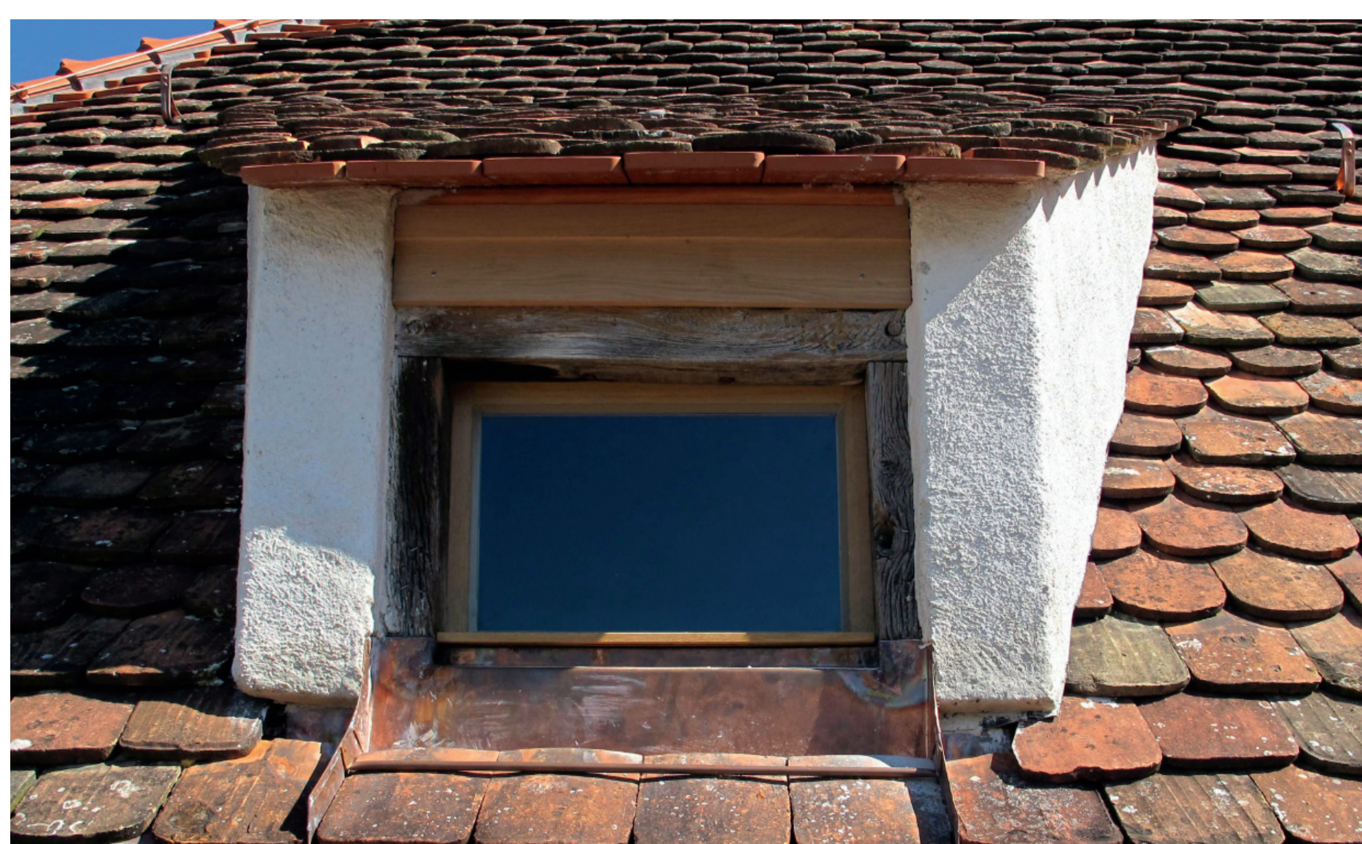
Rekonstruierte Dachgaube auf der Südseite
