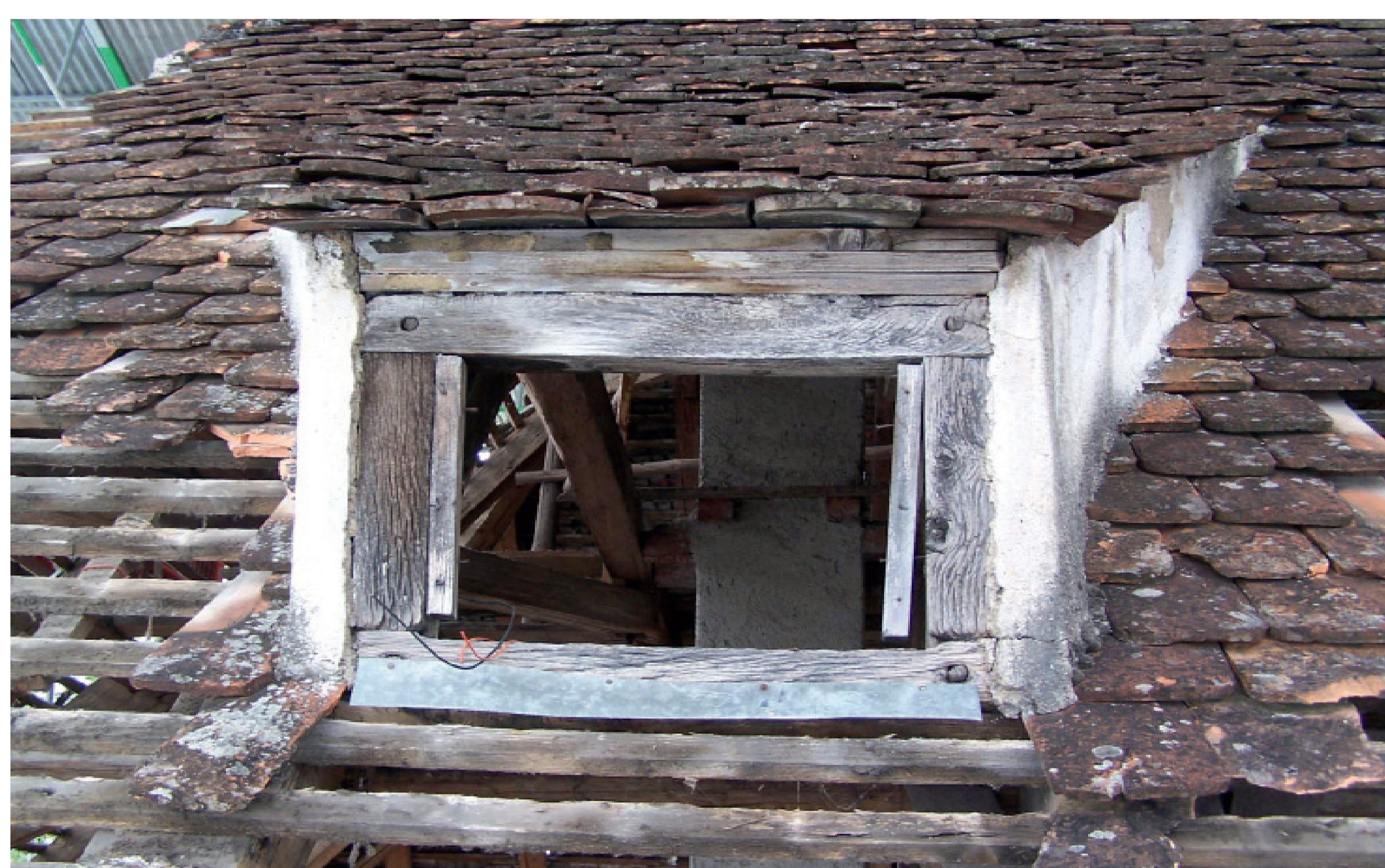
Originale Dachgaube der Alten Schäfllerei
