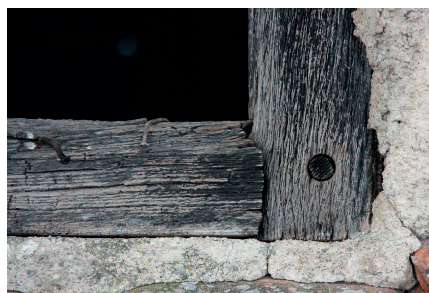
Die verwitterten Fensterstöcke aus Eichenholz haben Eckverbindungen aus Schlitz und Zapfen. Diese sind zusätzlich mit einem durchgehenden Holznagel fixiert. Ferner ist an der Innenseite ein Falz eingearbeitet.
