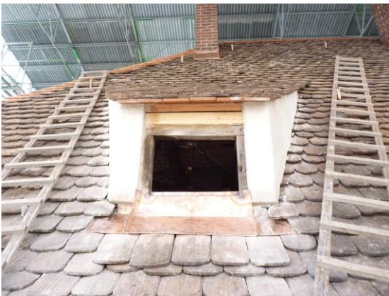
Bild 2: Rekonstruktion der Dachgaube nach der Bestandserfassung eines Restaurators.
